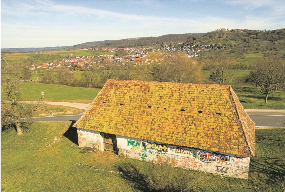
Das markante Bauwerk der alten Kelter oberhalb von Bruch bildet gleichsam das Tor zum Weissacher Tal. Fotos: A. Becher/J. Fiedler
